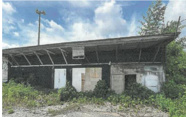
残置された倉庫・事務所
